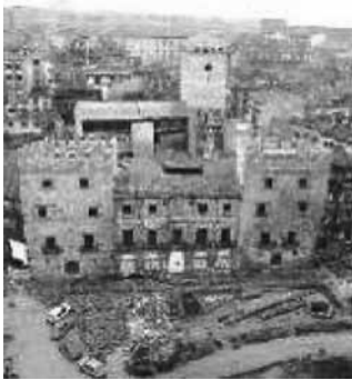
Figura 1: Excavaciones de la Fábrica de Salazones
